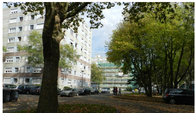
Rue du Tarn, un quartier encore arboré, qui va faire l'objet de lourdes rénovations. PHOTO DNA - FZ
