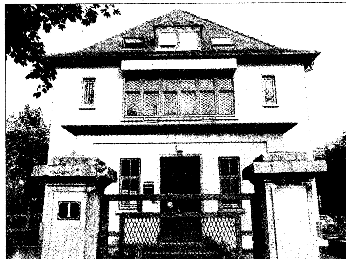
C'est au n° 1, rue de Bretagne, que sera installée la future épicerie solidaire tenue par l'association Caritas.
